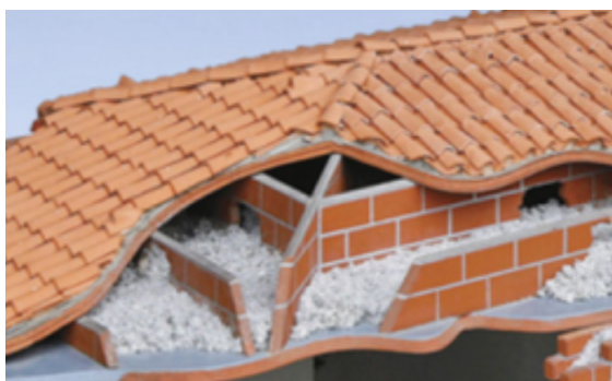
Esempio di sistema costruttivo del tetto in muricci e tavelloni con isolamento.
