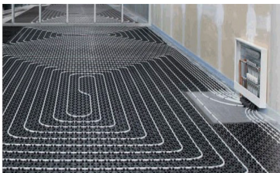
Esempio di sistema di riscaldamento a pavimento
